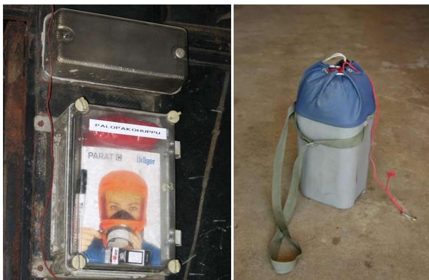
Kuvat 13 ja 14: Maanalaisissa tiloissa täytyy huolehtia henkilökunnan mahdollisuudesta suojautua savulta suojapaikkoihin tai maanpinnalle siirtymisen ajaksi palopakohuppujen ja/tai pakenemislaitteiden avulla (Lähteet: vasemman puoleinen kuva TTL:n Mainari-projekti ja oikeanpuoleinen kuva Marko Järvinen, Helsingin Pelastuslaitos )
